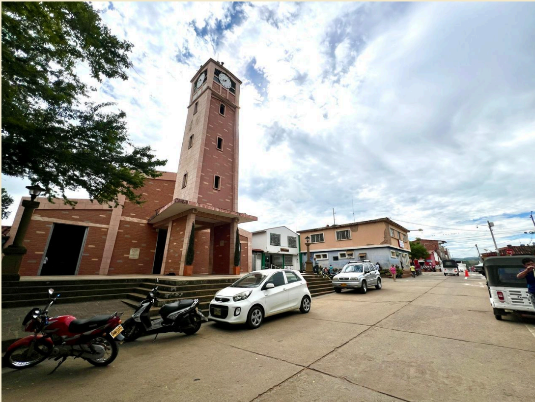
IMAGEN 14; FACHADAS DE PREDIO SOBRE CALLE Y CARRERA
