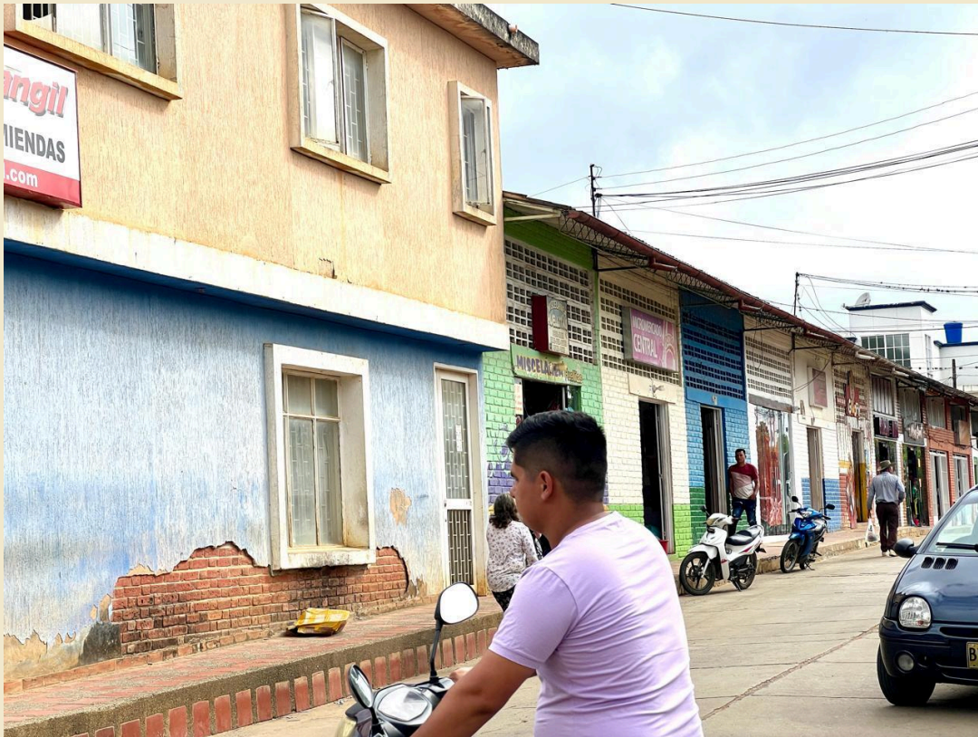
IMAGEN 15; FACHADAS DE PREDIO SOBRE CALLE Y CARRERA
