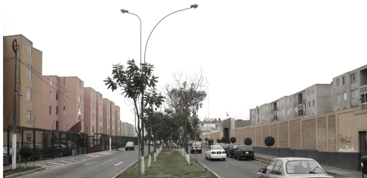
Fig. 27 Exteriores de conjuntos de vivienda, Lima
