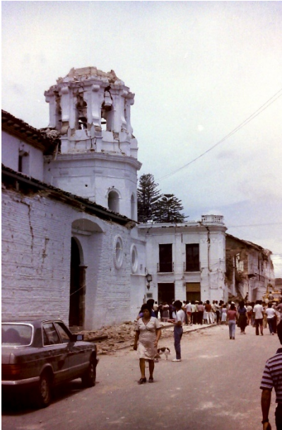
Imagen 1. Terremoto de Popayán. Daños en inmuebles patrimoniales construidos con tierra. 1983
