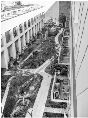
Figura 2. Vivienda Cooperativa BIGyard
